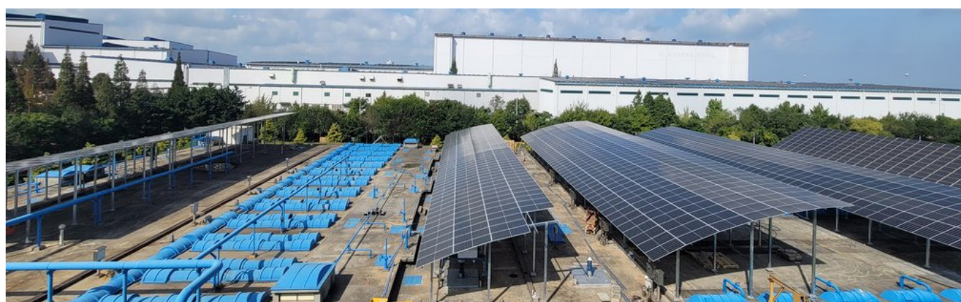
Photo d'installations de l'énergie nouvelle et renouvelable (énergie solaire) à la station publique de traitement des eaux usées à Kodaebugok, Ville de Dangjin
