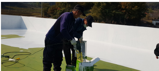
기후위기 안심마을(서천군 산동리) 쿨루프 시공 (시공 전 24.1℃ » 후 14.1℃)
