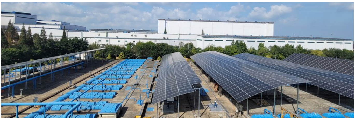
당진시 고대부곡 공공하수처리시설 신재생에너지(태양광) 설비 설치 사진
